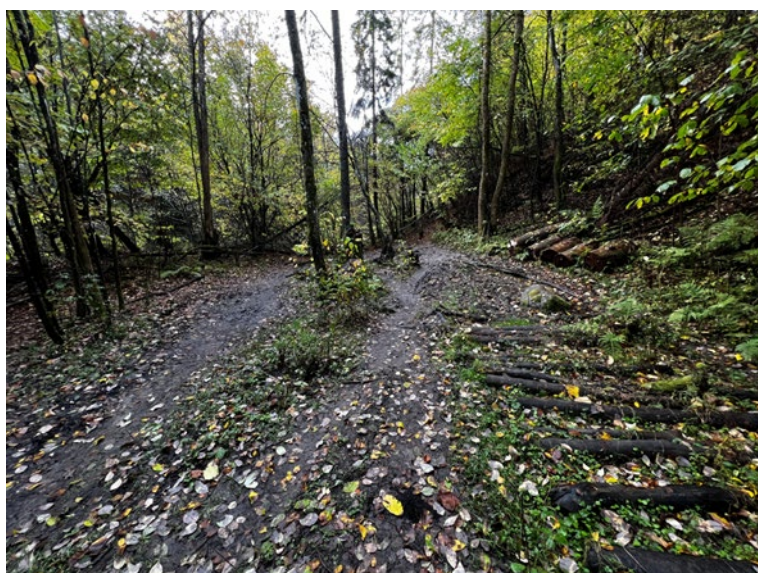
Figur 2-12 Der underlaget er fuktig, utvides stiene ofte, og et stort areal blir tråkket ned. Her er det forsøksvis lagt ut stokker for å lage en trasé som lar seg forsure når det er vått. Foto: Markus Strand.
