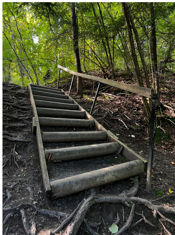
Figur 2-3 Trappa sør for Jarfyllingen er noe ujevn og har et vinglete rekkverk. Foto: Markus Strand.
