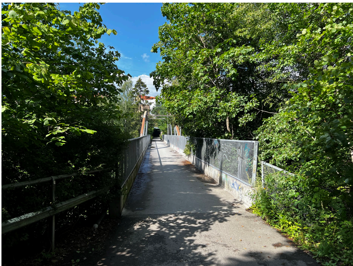
Figur 1-9 Jarbrua er en viktig ferdselsåre på tvers av Lysakerelva som en del av gang- og sykkelnettet. Forbindelsen føles åpen, og det er synlige stier ned mot elva på begge sider av brua. Foto: Markus Strand.
