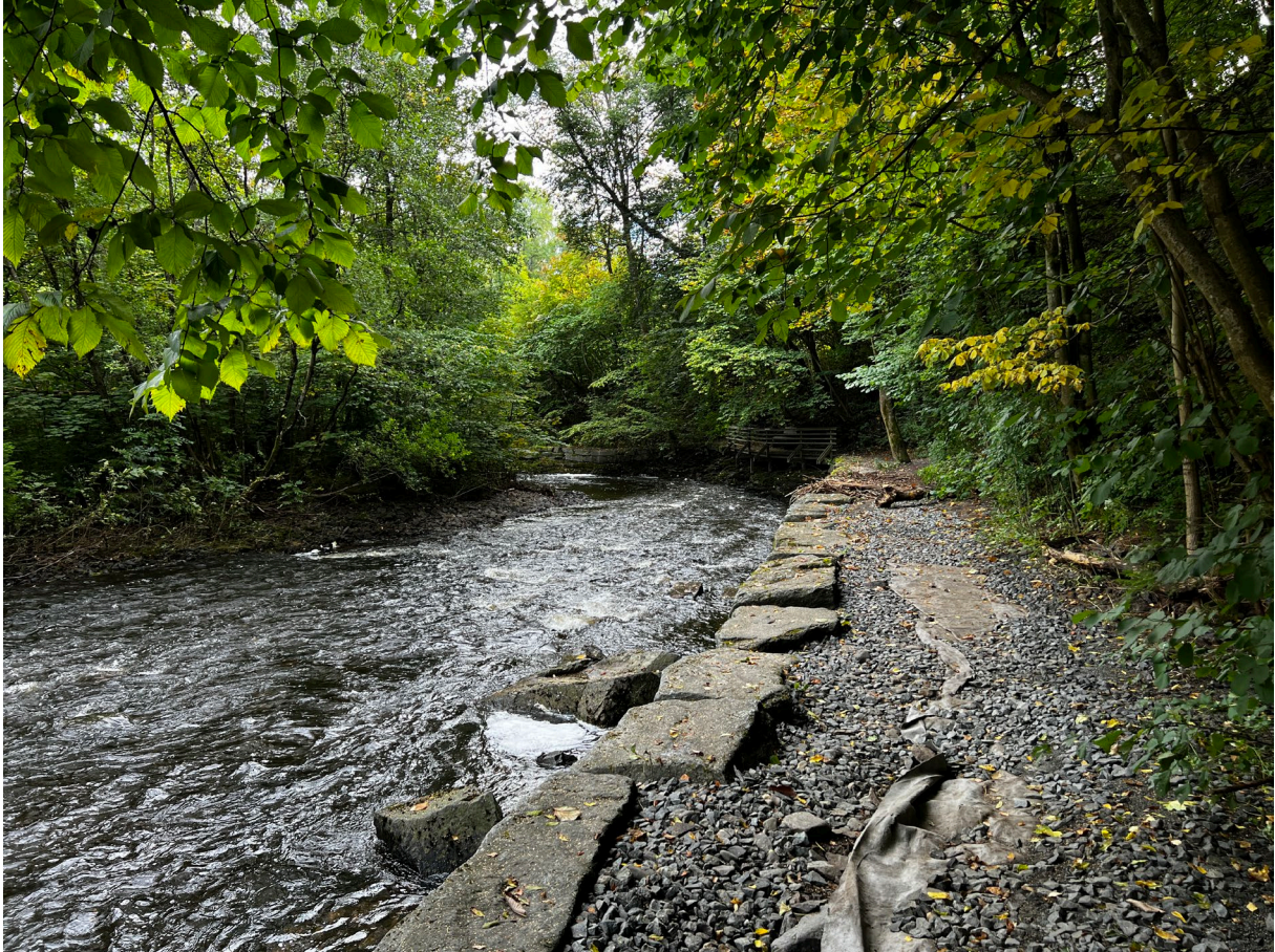
Figur 2-7 Turveitraseen sør for Jarfossen er en av strekningene som har blitt betydelig rustet opp de senere årene. Likevel har deler av toppdekket blitt vasket vekk etter de store nedbørmengdene høsten 2023. Foto: Markus Strand.
