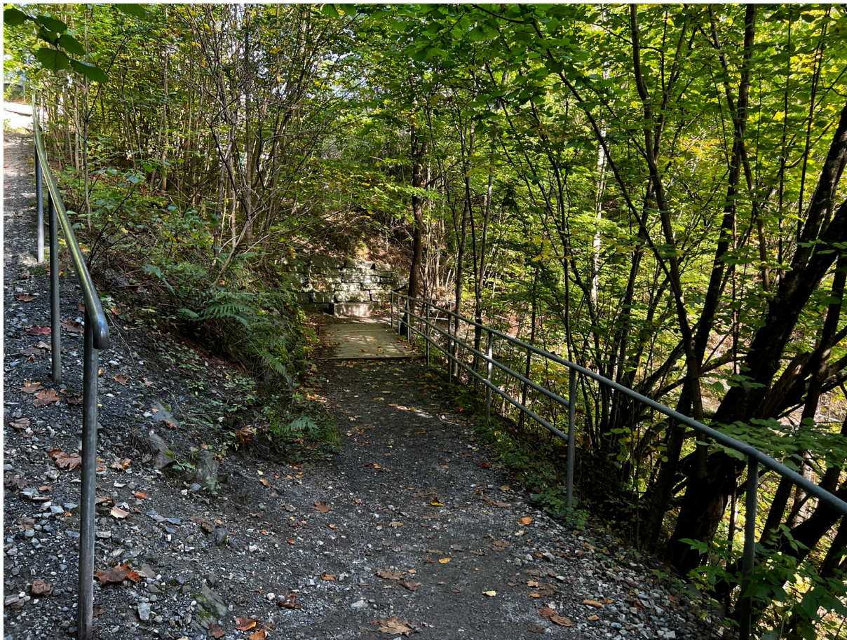
Figur 1-22 Sør for Jarfyllinga er flere av de bratte partiene forsterket og oppgradert, med ny opparbeidelse av stier, bordganger, murer og rekkverk. Til venstre i bildet skimtes stien opp til Fådpassasjen. Foto: Markus Strand.
